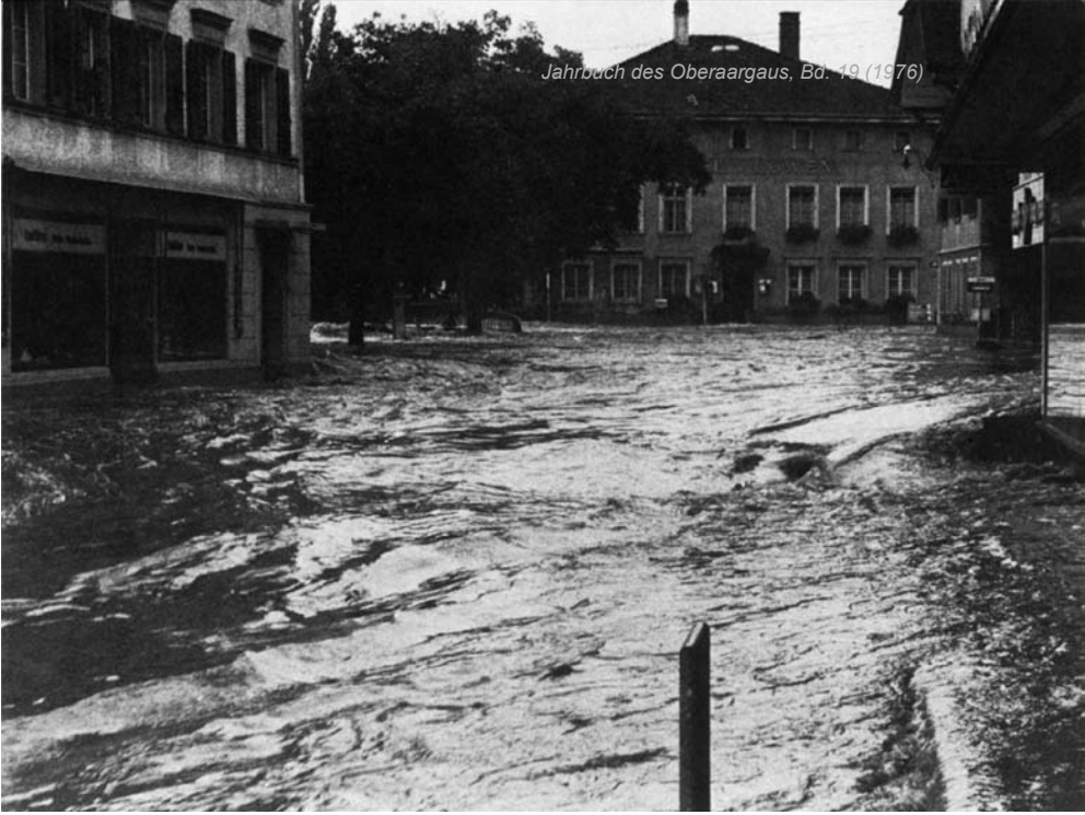
Langenthal. Hochwasser vom 30. August 1975, ca. 07.30 Uhr. Hüfthoch überflutet Marktgasse und Postplatz. Aufnahmen H. Scheidiger, Langenthal
